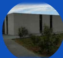
Centro de Alojamento de Emergência
